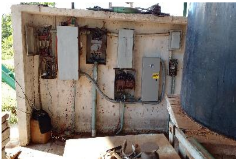
Banco de capacitores en operación
